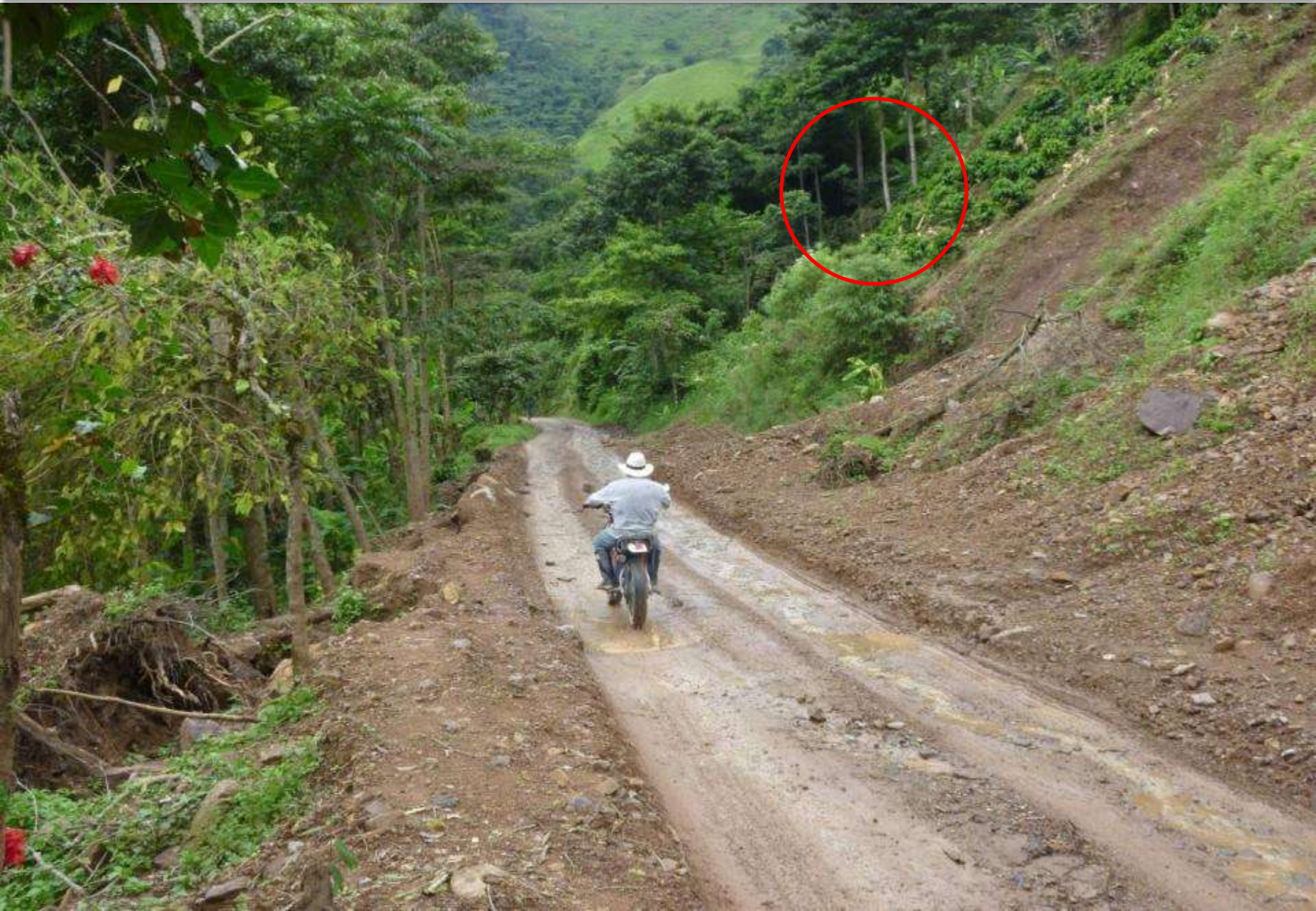
Estado de la base del talud, mayo 17 de 2011.
