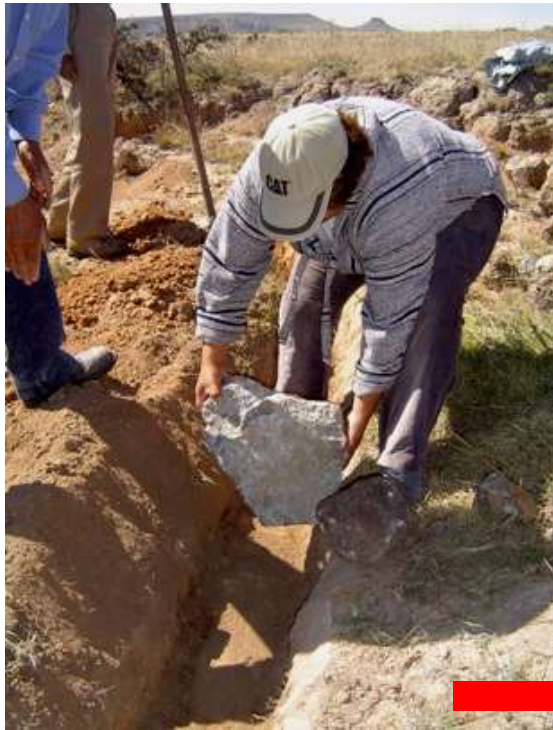
1. Apertura de zanja
